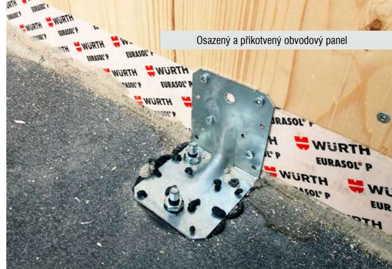
Veškeré otvory jsou již předem připraveny na CNC obráběcím centru řízeném počítačem
